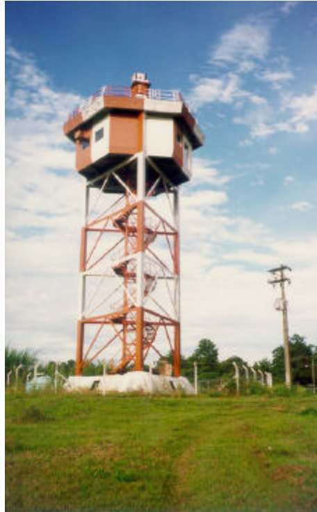
Fig. 3.2 - Torre localizada no CTA, em São José dos Campos, onde os instrumentos estão instalados.
